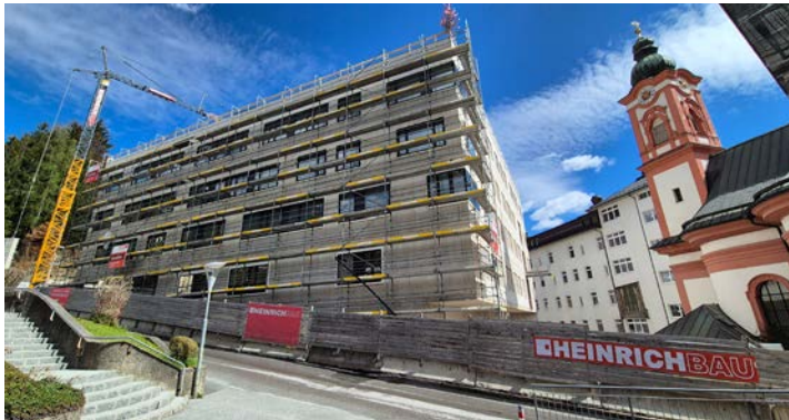
Baufortschritt Neubau E, April 2025
