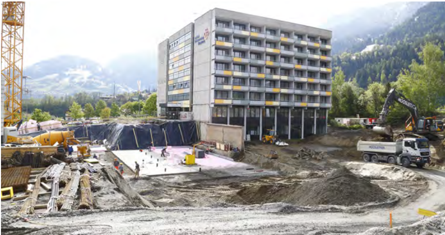
Baufortschritt Campus Schwarzach Anfang Mai 2019.
